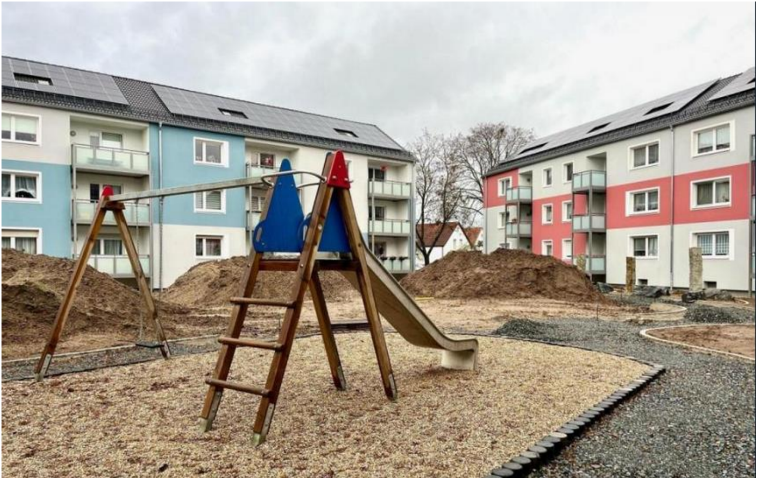
Sanierte und gedämmte Häuser mit Photovoltaikanlage
