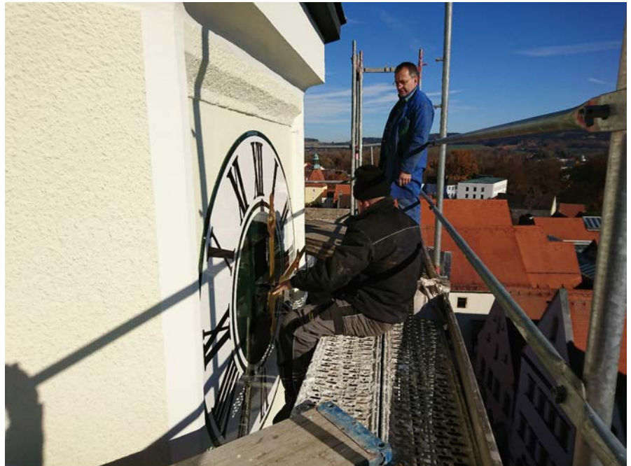
Arbeiter montieren die neuen, vergoldeten Zeiger der Turmuhr
